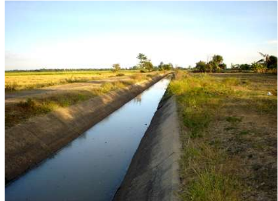
คลองตาดคอนกรีต
