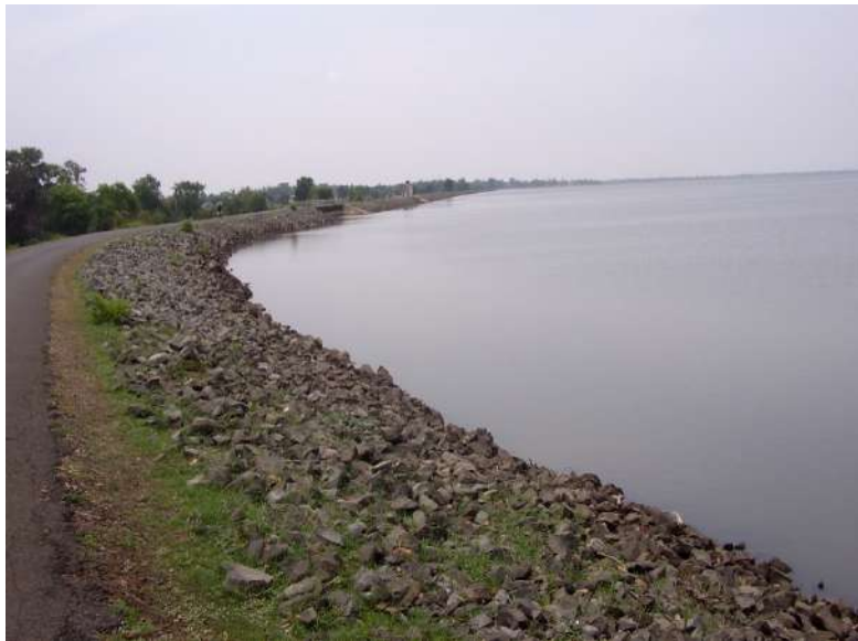
ภาพที่ 5.4 อ่างเก็บน้ำห้วยตลาด อำเภอเมือง จังหวัดบุรีรัมย์
